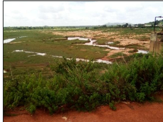
Photo n°2 : barrage en saison pluvieuse
